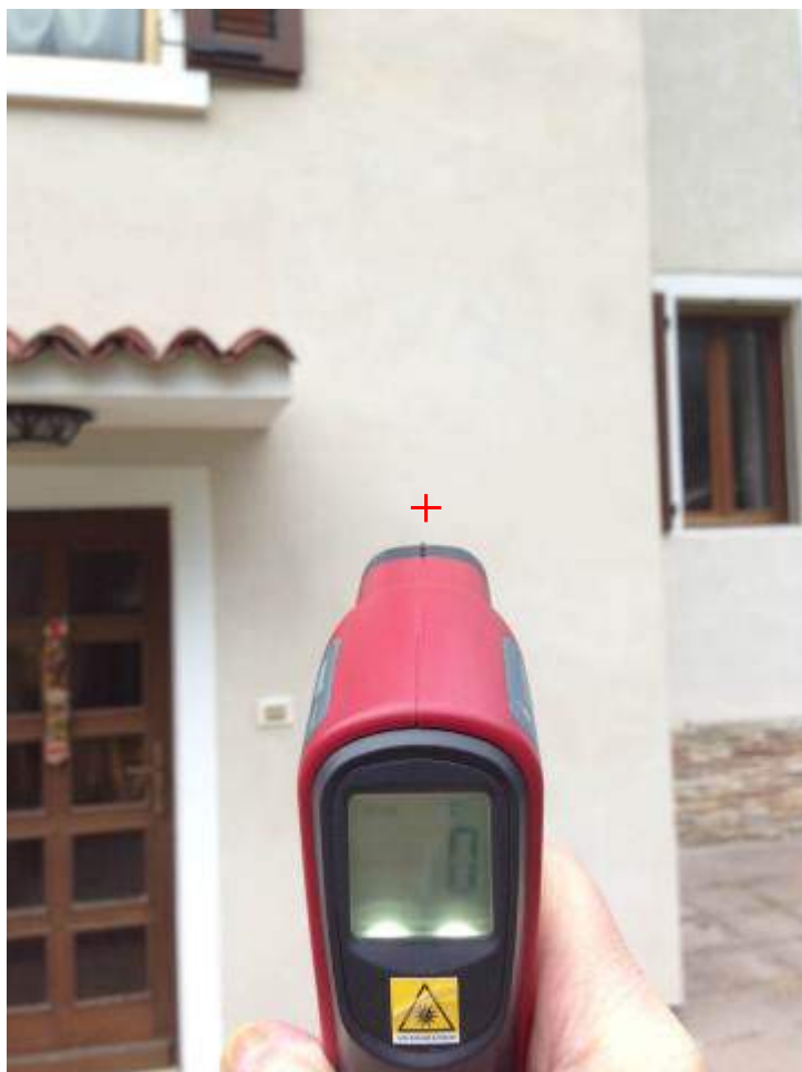
1 - Misurazione esterna su muratura con cappotto nanotecnologico KR2
