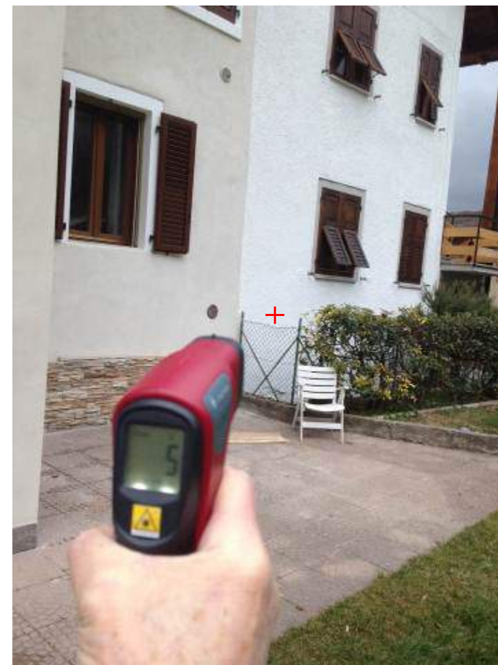
2 - Misurazione esterna su muratura senza cappotto
