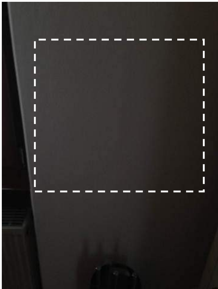
Muro perimetrale sala con cappotto nanotecnologico KR2 (5mm) esterno
