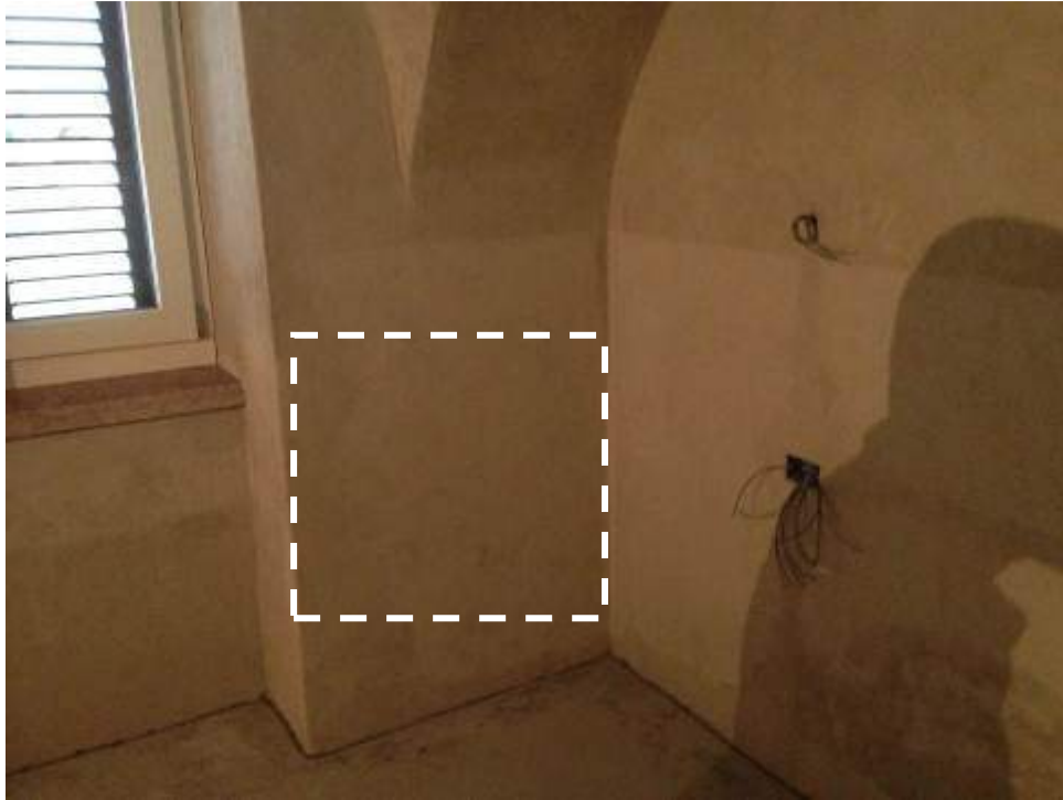
02-Parete muro perimetrale appartamento piano interrato
