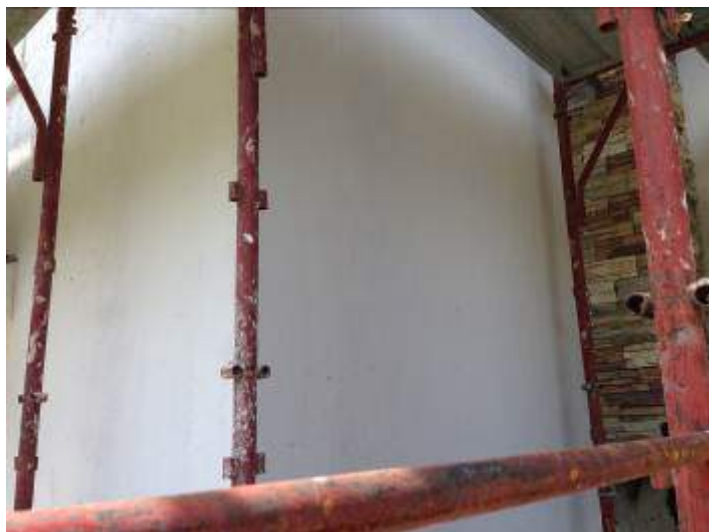
Dettaglio superficie finita con applicazione 6mm di termoisolante
