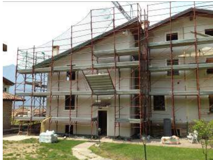
Seconda applicazione di KR2 3mm
